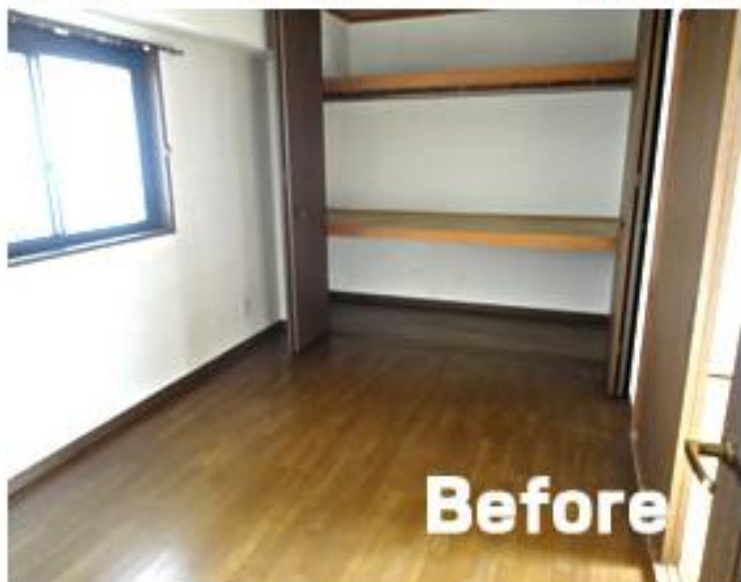
洋室のフローリング床にフロアタイルを上貼り
